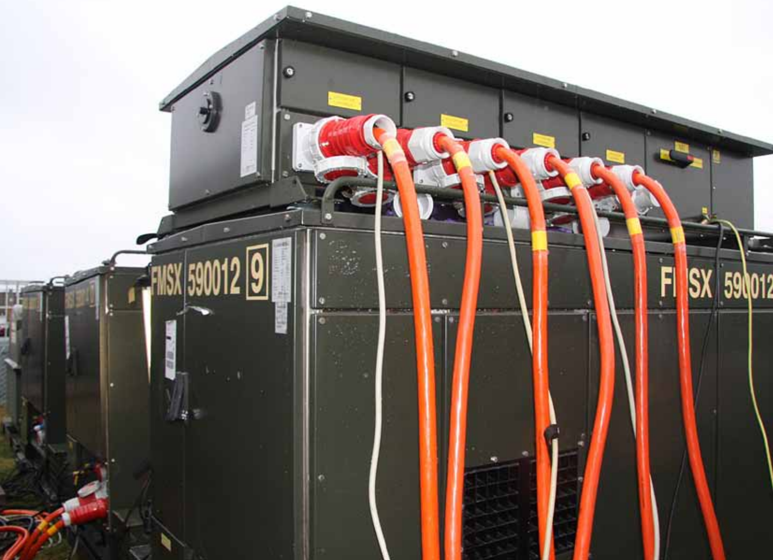
Elverk som strömförsörjer flygledningscentralen vid NBG 11.
