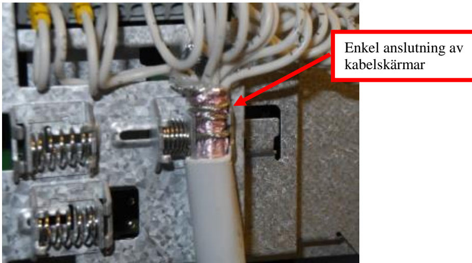
Exempel på lösning för att ansluta kabelskärmar.
